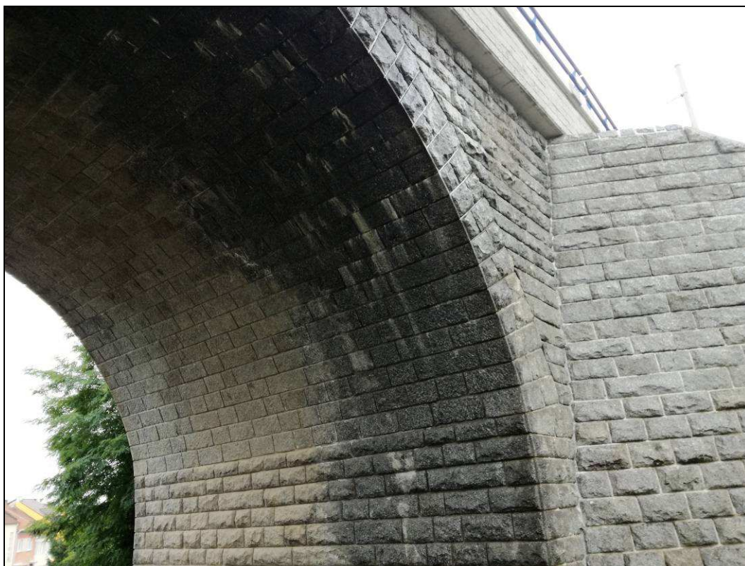
Obr. č. 3 - pohled na klenbu a opěru - směr Královo Pole - četné průsaky skrze NK
