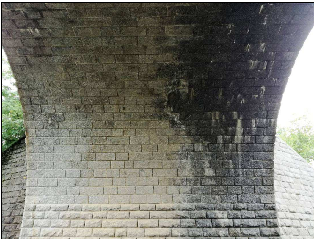
Obr. č. 4 - pohled na klenbu a opěru - směr Královo Pole - četné průsaky skrze NK
